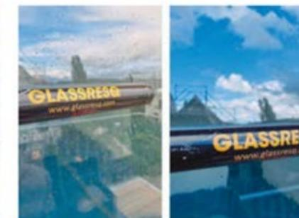
Vorher/nachher: Alkalische Substanzen und Mörtel hinterlassen im ausgehärteten Zustand Flecken.
