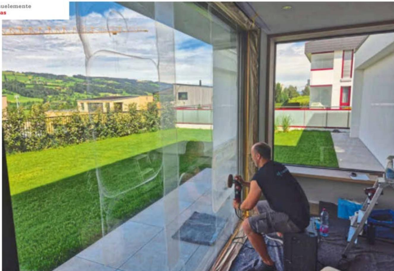
Das einzigartige GlassResQ-Verfahren zur Glassanierung: Dieses staubfreie Schleif- und Polierverfahren garantiert unter bestimmten Temperaturbedingungen eine nahezu abrasionsfreie Glassanierung, ohne dass sich das Glas verdünnt oder wellig wird.
