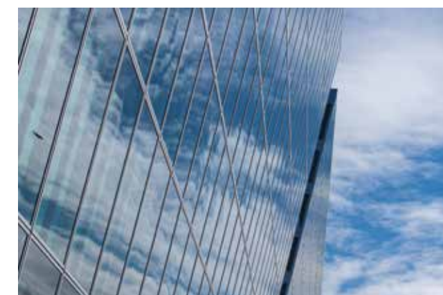
THE CIRCLE Aéroport de Zurich
